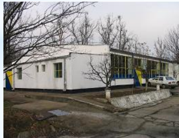
Parc Industrial Plopeni
